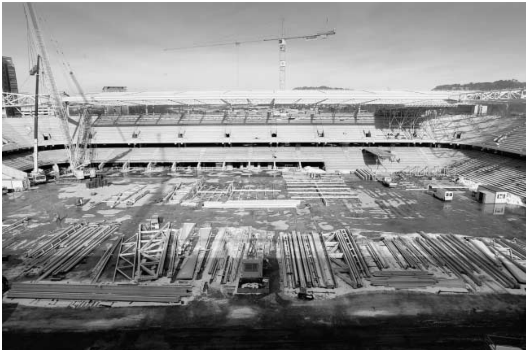
Grossbaustelle Stade de Suisse Wankdorf Bern: Das Stahlskelett für das Dach auf der Gegentribüne steht, jetzt kann es verkleidet werden.
